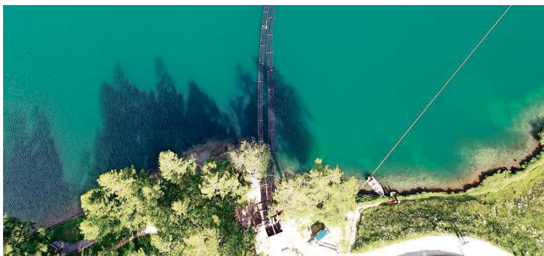
Baustelle im Lej da Champfèr: Bei der Seeverlegung wird das Kabel über den Grund des Sees geführt.
